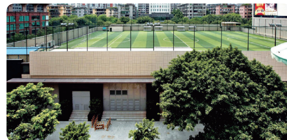
广州 110kV 中旅变电站
