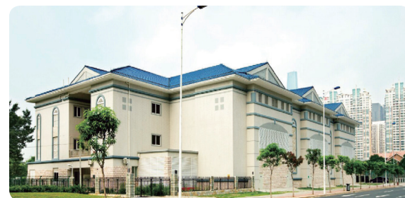
广州 220kV 猎德变电站
