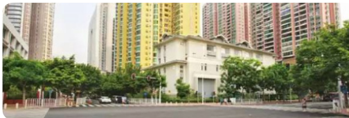
广州 110kV 花穗变电站实测昼间 51.3 分贝，夜间 49.2 分贝
